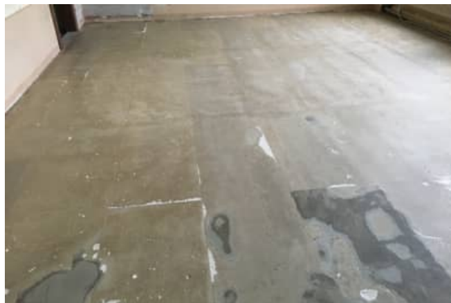
Vecchio sottosuolo da ristrutturare.
