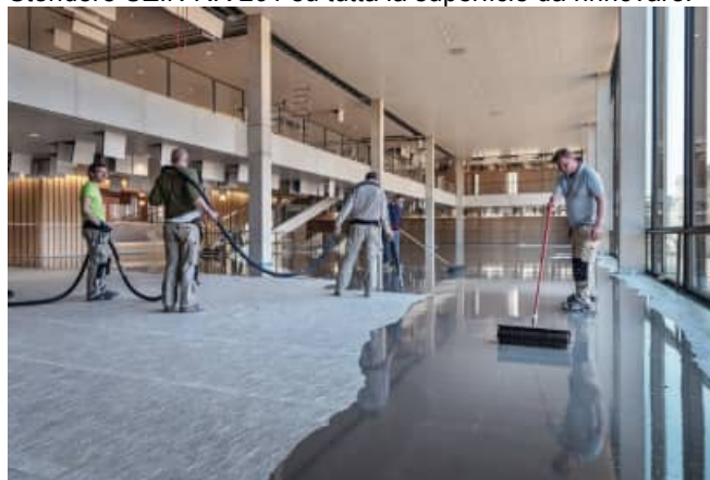
Stendere UZIN RR 201 su tutta la superficie da rinnovare.
