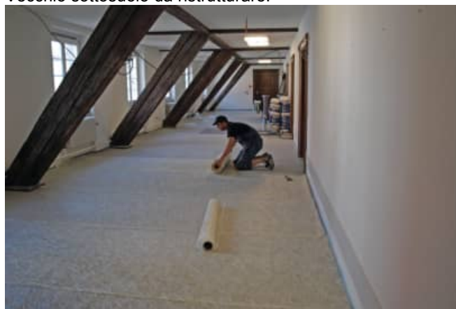
Stendere UZIN RR 201 su tutta la superficie da rinnovare.
